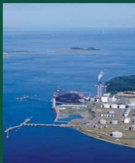
FG har fortaget undersøgelser for fundering af ændringer af kulmodtageanlægget ved Stignæsværket.
