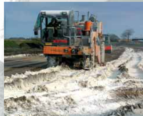
Jordstabilisering med kalk er en miljørigtig løsning, idet man bl.a. kan undgå bortkørsel af store mængder råjord og tilkørsel af sand og grus. (Billedet er venligst udlånt af Inreco A/S).
