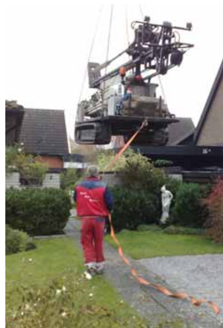
En boremaskine løftes ind i en have med kran
